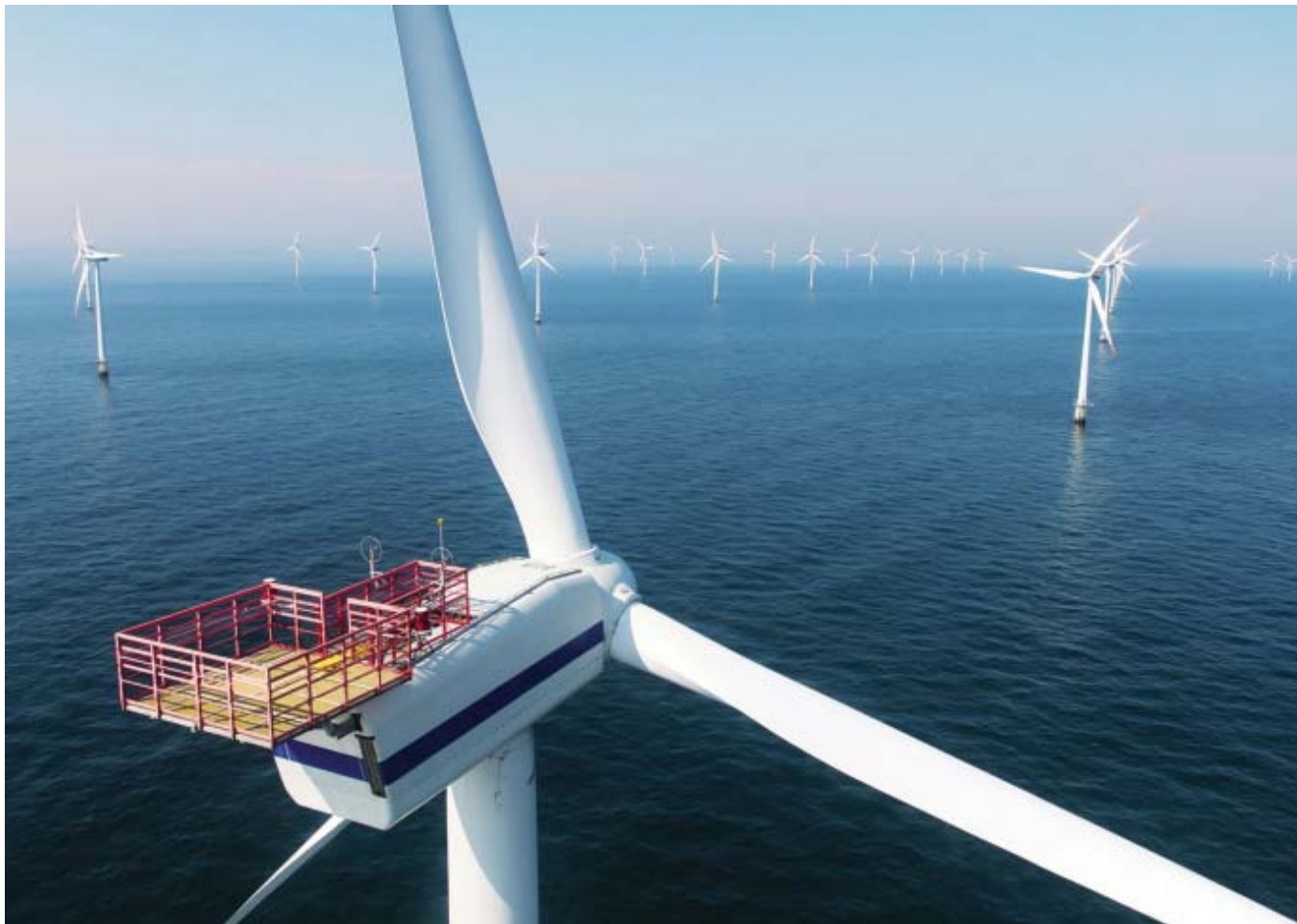
Фото. 1. Морские ветряные электростанции сталкиваются с самыми жесткими условиями окружающей среды (C5 - X). В этом случае антикоррозионные грунтовки являются обязательными.
