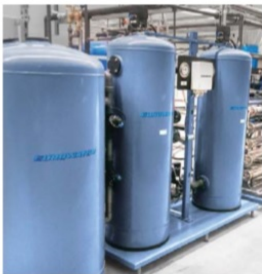
Фото. 5. Фильтр с активированным углем перед умягчением и двухступенчатым RO в эксплуатации у производителя автозапчастей.
