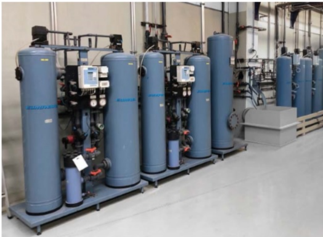
Фото. 9. Несколько линий производства DI воды для предварительной обработки колес из легкого сплава.
