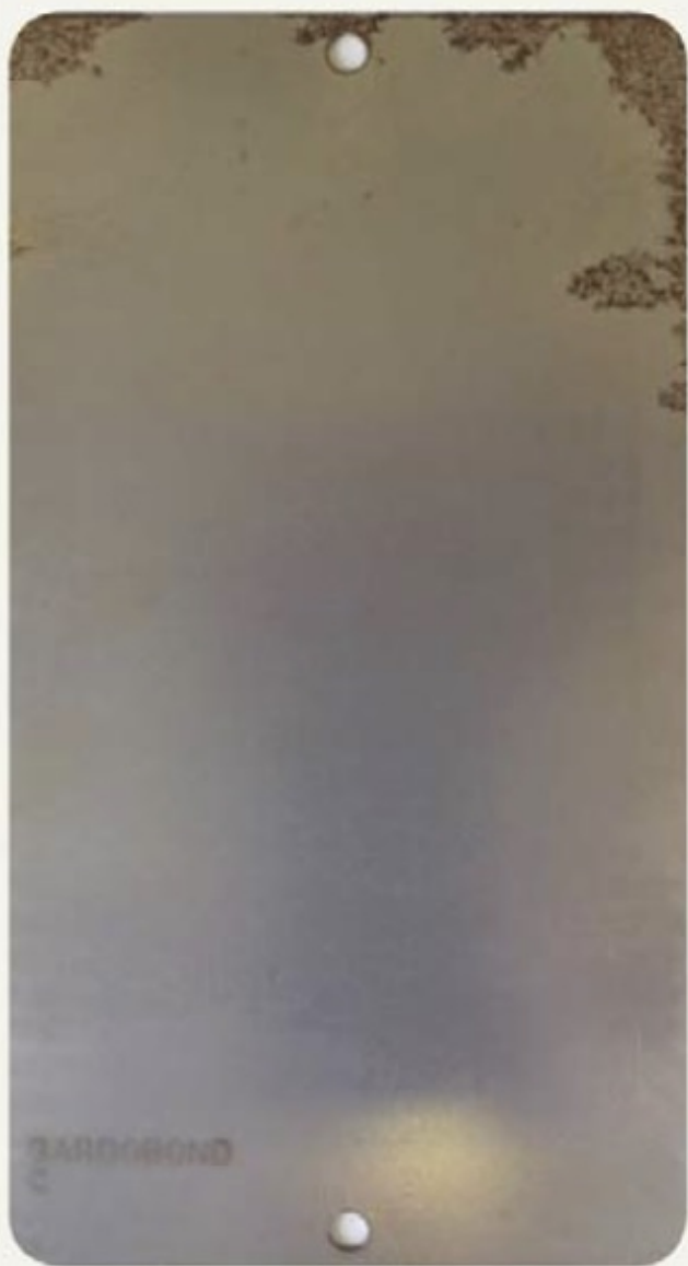
Перед обработкой: поверхность с коррозией
