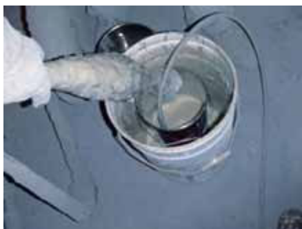
Фото. 9. Така «обросла» всмоктувальна трубка розпилюючої установки свідчить про те, що ця компанія не дбає про своє обладнання.
